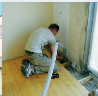
sticht der innovative Kerndämmstoff SLS 20 F hervor. Dieses einzigartige Produkt findet Verwendung bei der Verfüllung von Hohlräumen im zweischaligen Außenmauerwerk. SLS 20 F wird von Poesis exklusiv vertrieben und ist nur über den Verbund erhältlich. „Dieses Glasgranulat füllt die
