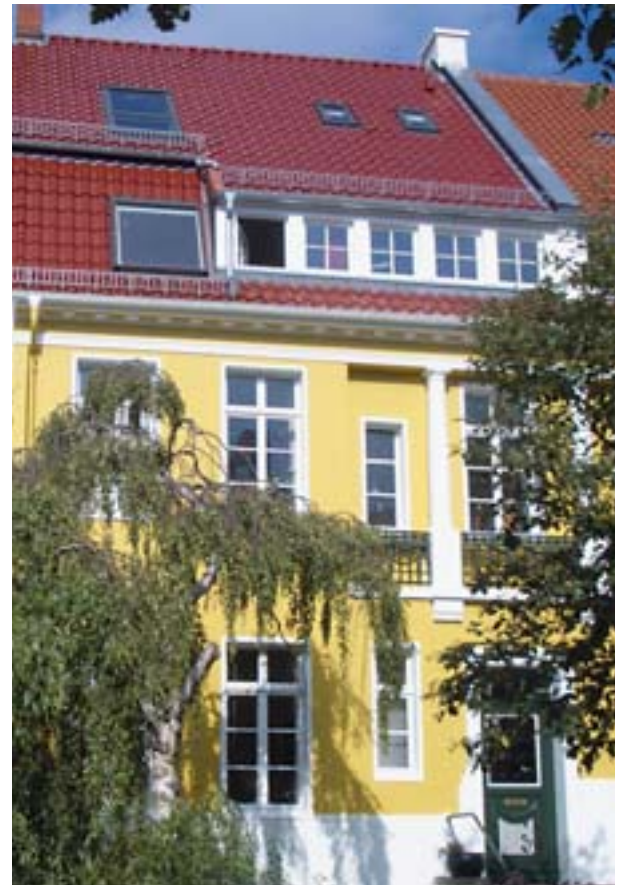
Beim Ausbau des Dachgeschosses wurde das Dach dieses Reihenhauses vorbildlich gedämmt.
