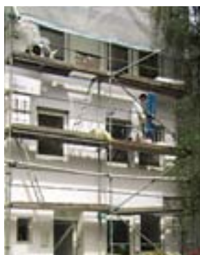
Anbringung eines Wärmedämm-Verbundsystems an einem Reihenhaus
