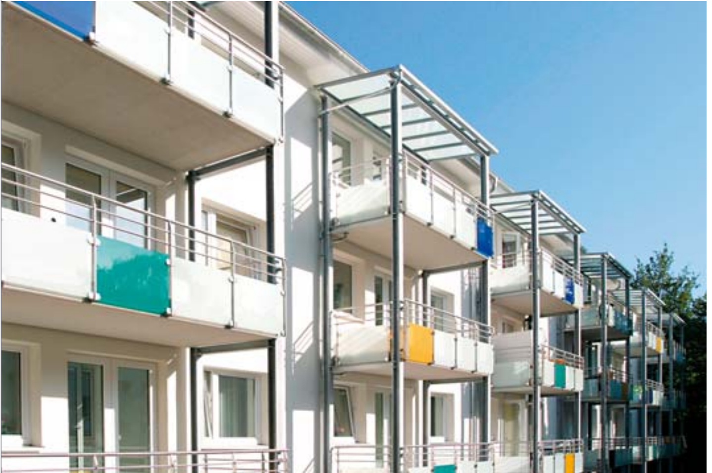
Vom Altbau zum Niedrigenergiehaus: Modellsanierte Mehrfamilienhäuser der GEWOBA am Steffensweg
