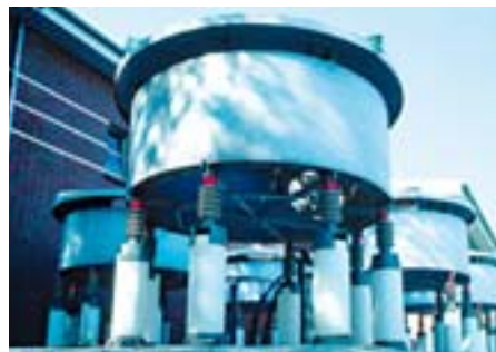
50-Hertz-Kompensationsspulen des vollstatischen Frequenzumrichters
