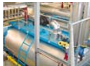
Neue Heizzentrale mit Blockheizkraftwerk bei der Bremer Straßenbahn AG
