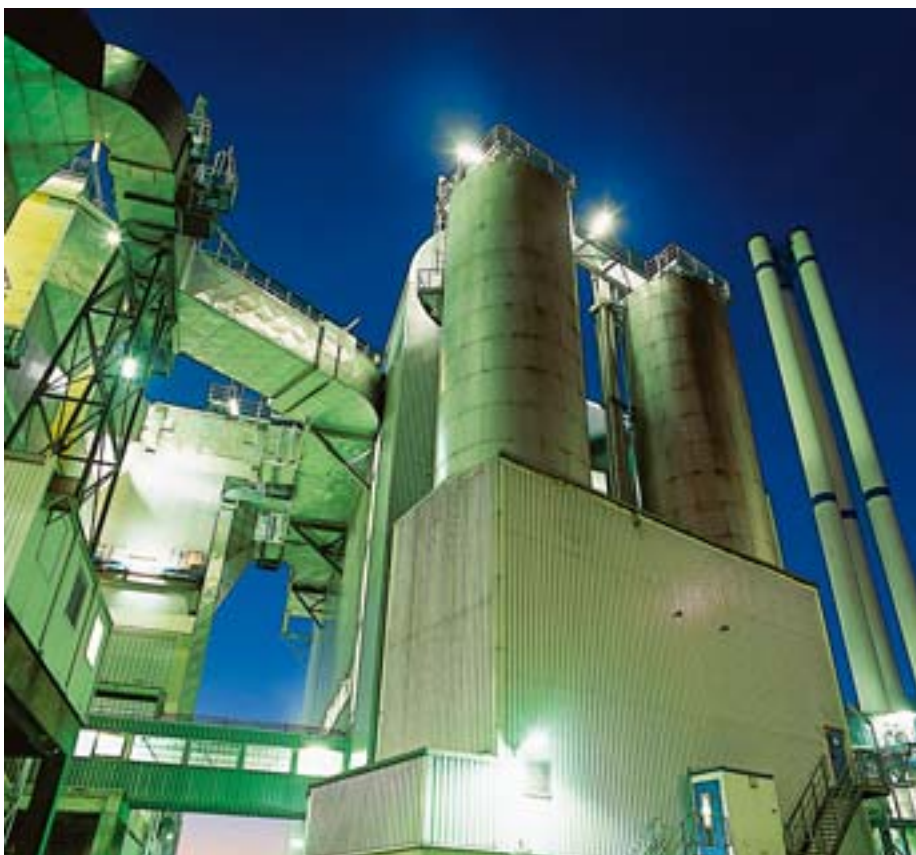
Das Müllheizwerk Bremen liefert Strom und Wärme.
