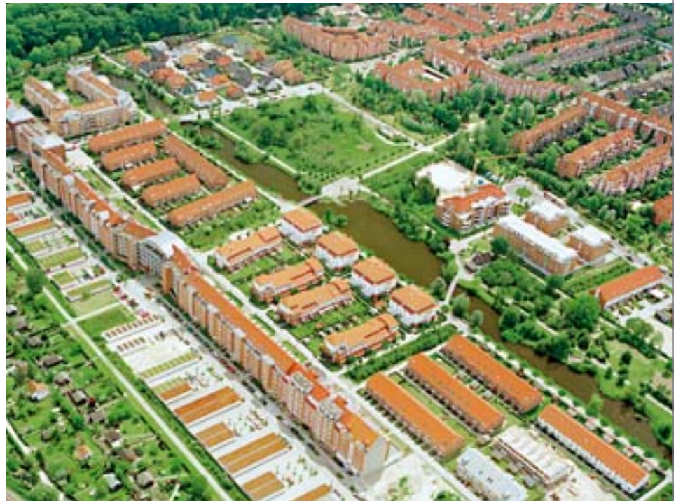
Mit Fernwärme versorgt: Wohngebiet Weidedamm III
