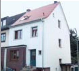
Kerngedämmtes Einfamilienhaus (o.) und Reihenendhaus, gedämmt mit einem Wärmedämm-Verbundsystem (u.)
