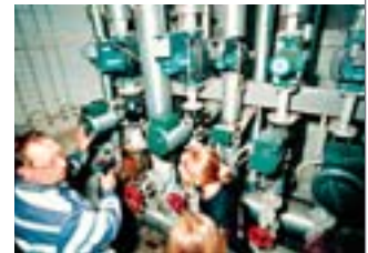
Praxisunterricht in der Heizzentrale eines Schulgebäudes
