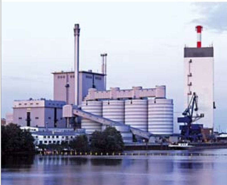
Heizkraftwerk in Bremen-Hastedt; li.: Steinkohleblock 15
