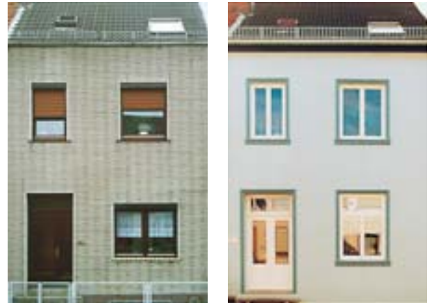
Remodernisiert mit Unterstützung der Bremer Energie-Konvens und des Senators für Bau, Umwelt und Verkehr: Ein Bremer Reihenhaus vor (li.) und nach Durchführung der Wärmeschutzmaßnahmen (re.)
