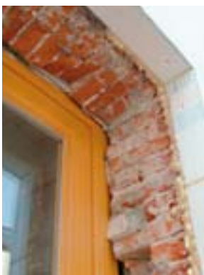
Detail einer gedämmten Gebäudefassade im Rohbau
